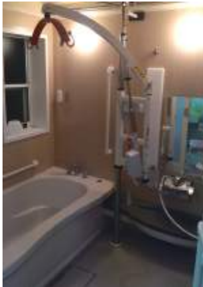
▲リフト浴設置
